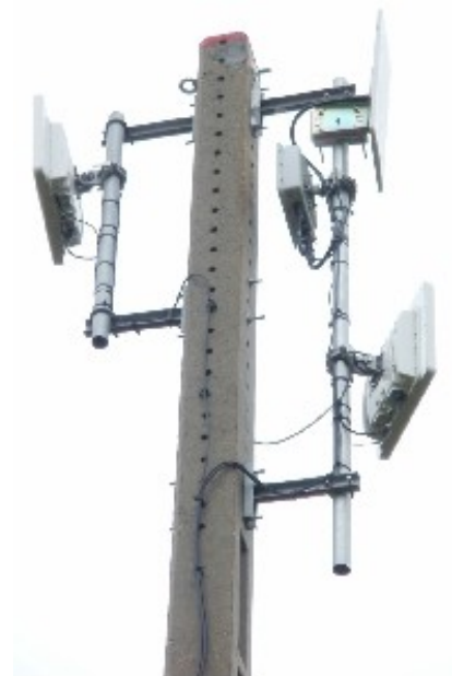
Estación Base formada por tres sectores
