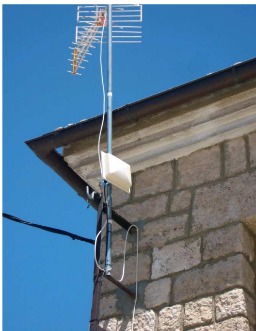
Terminal de usuario WiMAX en el ayuntamiento de Campisábalos
