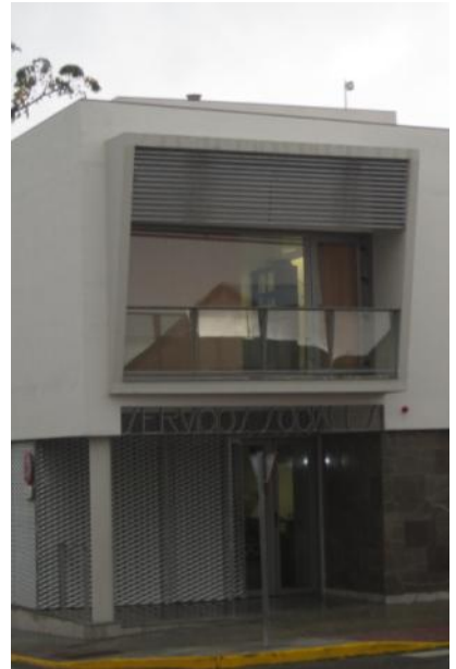
Instalación en Servicio Social
